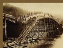
明治31年 架替工事
