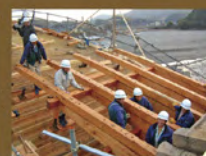
平成13年 架替工事 桁組
