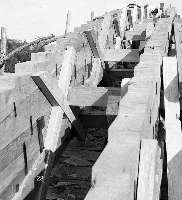
写真 2-20 「鞍木」は、アーチリブの主要構成材である小径部材間のせん断力の伝達を抑える役目を果たしている
