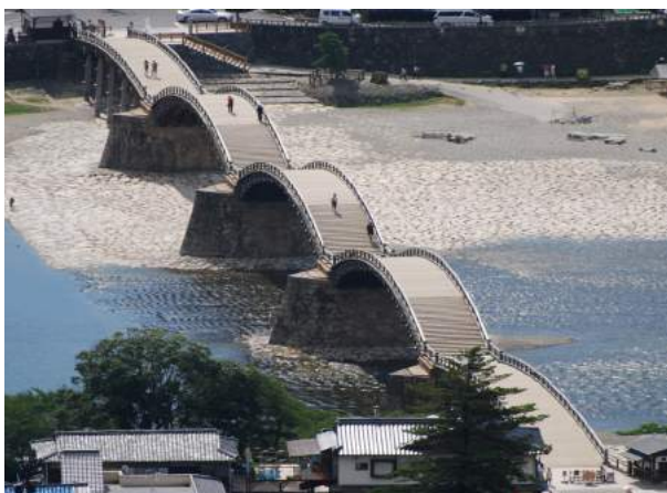
写真 2-1 錦川を渡る錦帯橋（2009）
