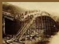
明治31年 架替工事
