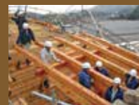
平成13年 架替工事 桁組
